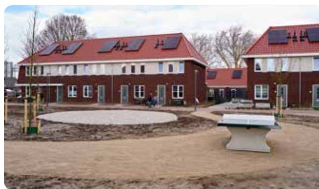
14 eengezinswoningen aan het Julianplein te Barneveld (een deel van het totale project, in 2019 volgen de overige woningen)
