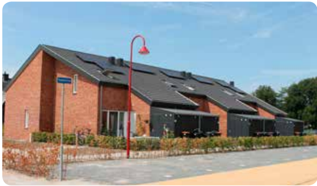
20 appartementen en 10 rug-aan-rug woningen in de wijk Eilanden-Oost in Barneveld;
